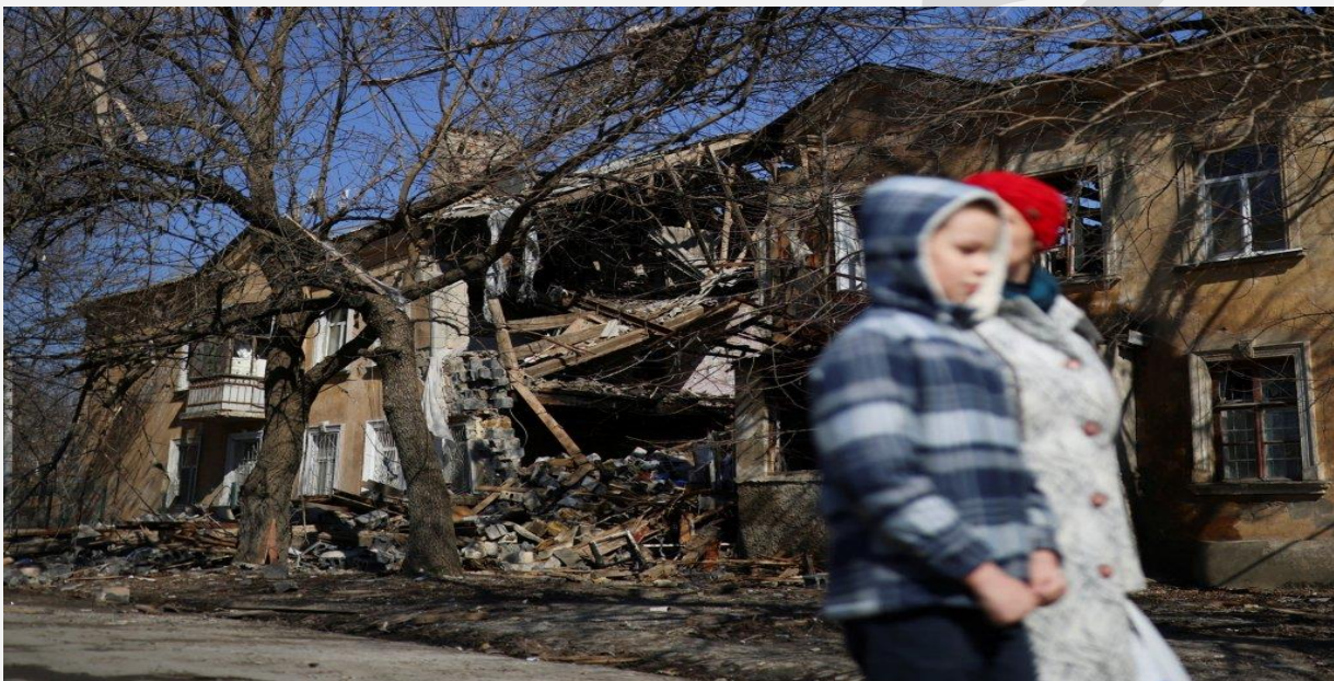
یک ساختمان بمباران شده در شهر میکولایف، ۲۴ مارچ ۲۰۲۲. عکس از رویترز
