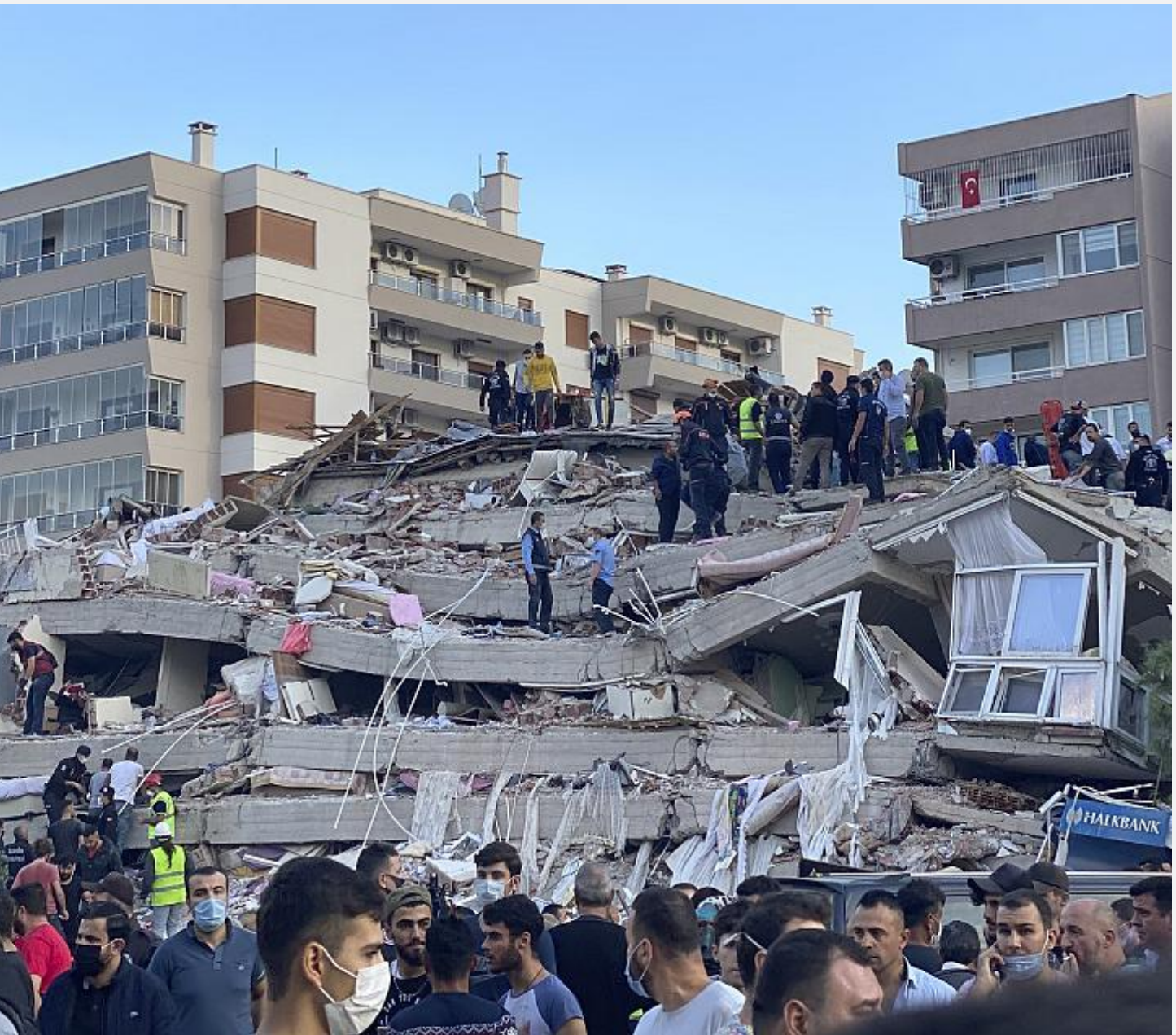
تخریب برخی ساختمان‌ها در بخش‌های زلزله زده استان ازمیر Ismail Gokmen/AP
